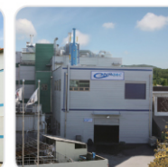
NR G&C No. 2 Plant NR G&C 二工厂
